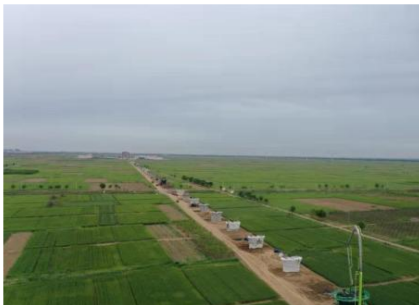
石衡沧港城际铁路
